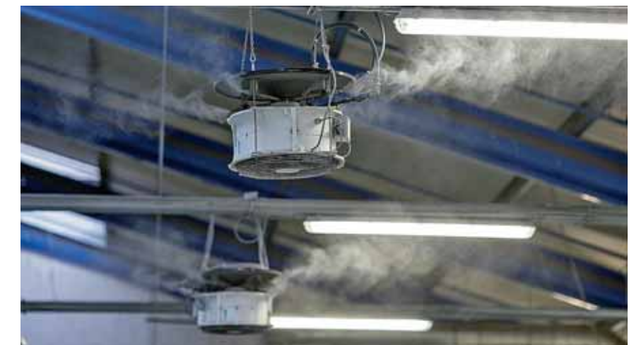
Ventilatoren zur Luftbefeuchtung bei Garant
